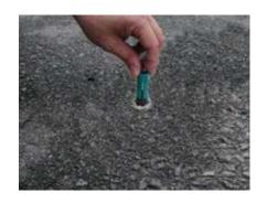
アンカーボルトを埋め込みます (ボルト直径15ミリ 長さ60ミリ)
